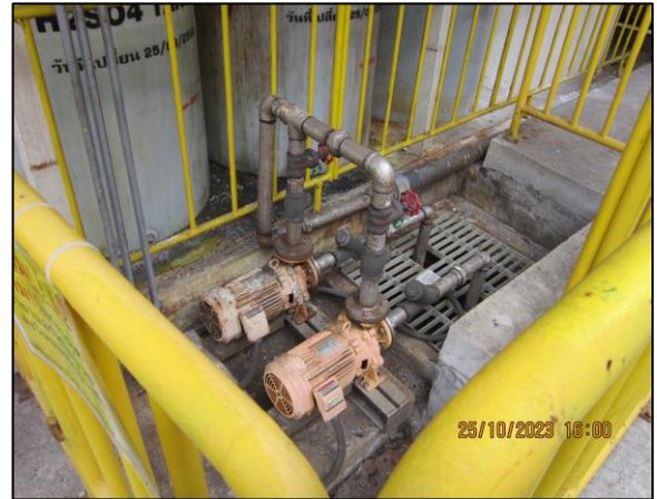
ปั๊มสูบน้ำและบ่อรวบรวม (Sump Pit)
