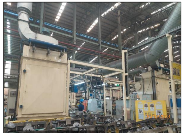
ภาพที่ 2.2-4 Bag House Filter ขนาดเล็ก
