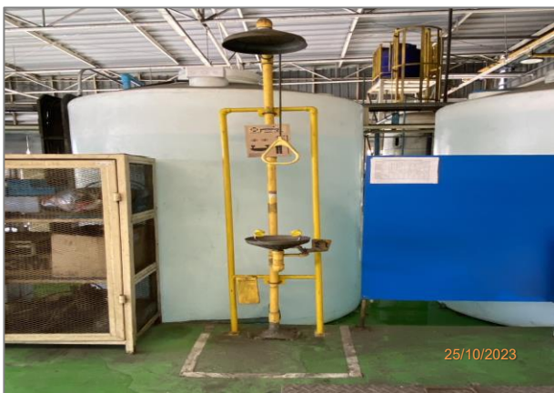
ภาพที่ 2.2-38 อุปกรณ์และแผนผังตำแหน่งติดตั้งอุปกรณ์ล้างตาและฝักบัวฉุกเฉิน
