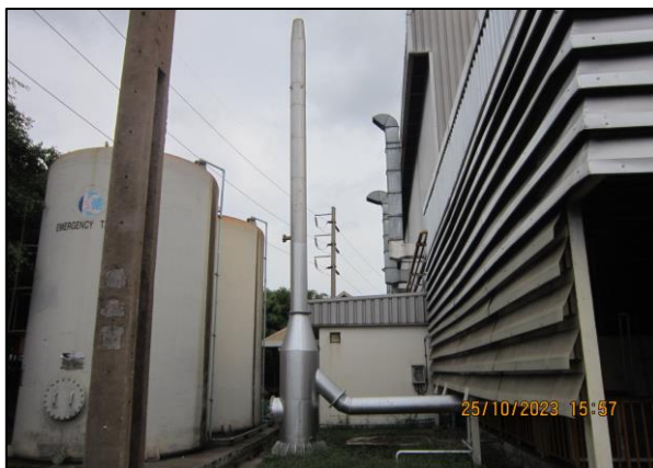
ภาพที่ 2.2-5 ปล่องระบายอากาศจากหม้อไอน้ำ
