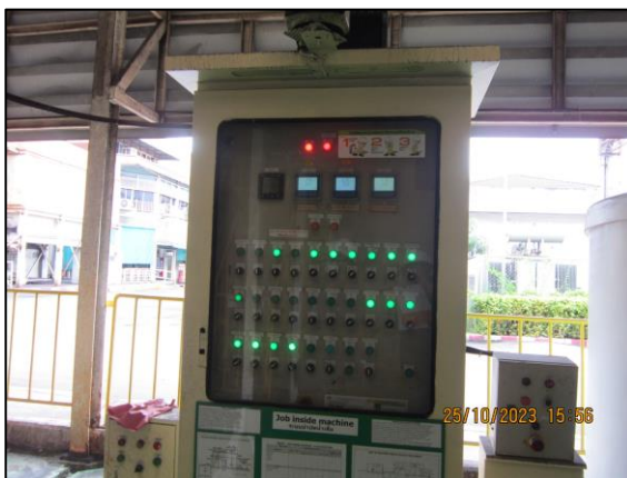
ภาพที่ 2.2-27 ระบบตรวจวัด pH อัตโนมัติ
